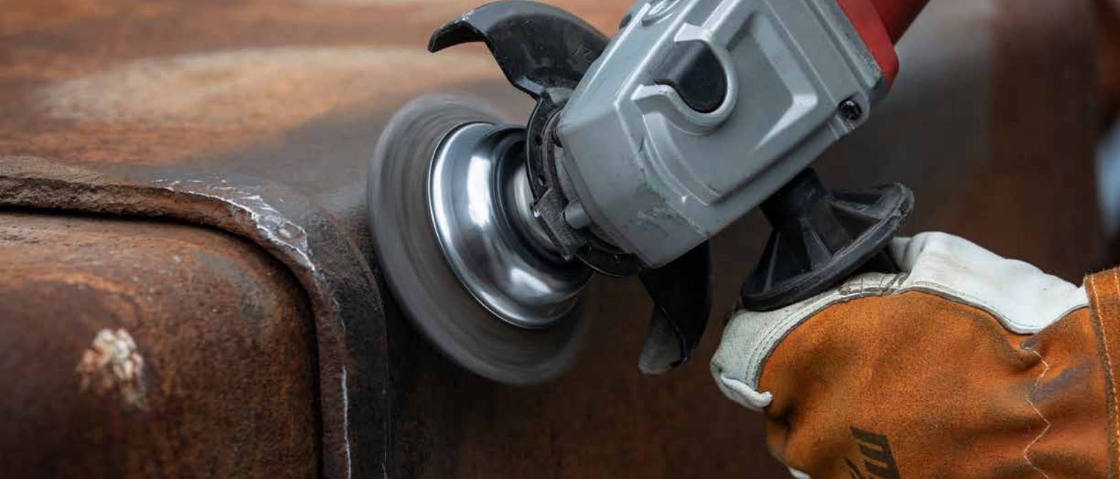
Copa de alambre ondulado removiendo óxido de un riel.
