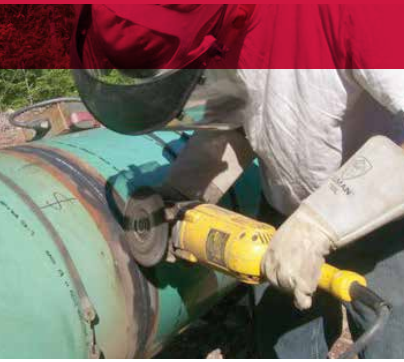
Limpieza de soldadura en unión de tubería
