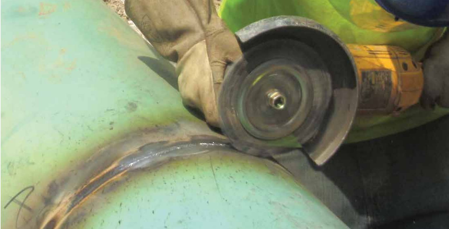
Limpeza de soldadura de pase de raíz en tendido de tubería.
