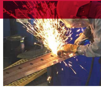
Utilizando un cono para limpiar imperfecciones de las superficies.
