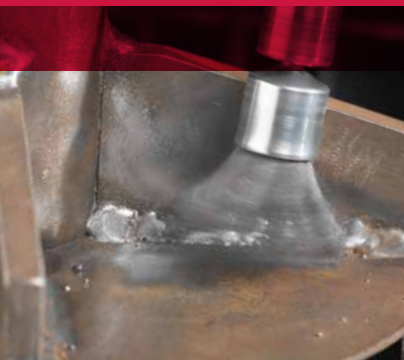
Limpieza de soldadura en área de difícil acceso.
