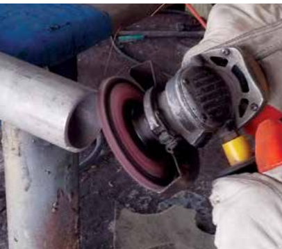
Desbaste y biselado de tuberías de acero inoxidable con un disco laminado abrasivo Saber Tooth.
