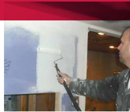
Applying primer to new drywall.
